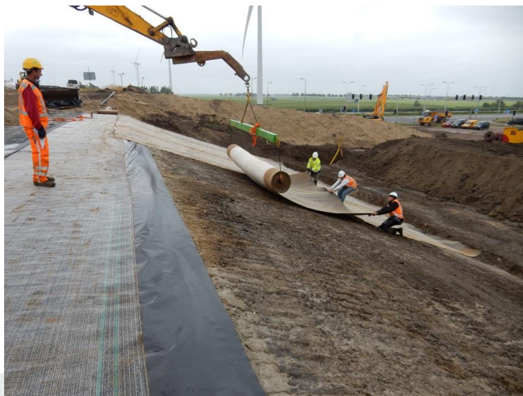
Foto: Toepassing bentonietmat.
